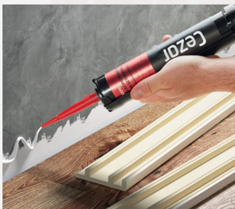
Montaż na klej
